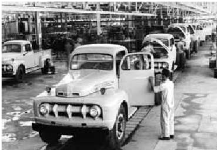
Linha de montagem de uma fábrica de veículos no passado: os operários instalavam a maioria das peças
